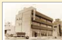
建設中の旧本社
