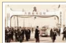
東大阪金物団地着工(1967年)
